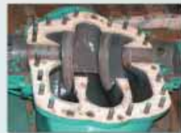
Восстановление полностью изношенной поверхности
